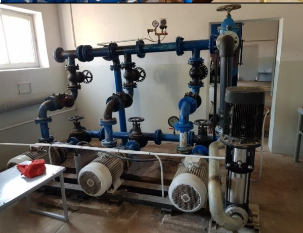
Pompownia II° z pompą CR20-6/7,5 kW, pompownia zostanie zdemonstrowana przez inwestora, pompę CR20-6/7,5 kW wykonawca zamontuje w nowym zestawie hydroforowym.
